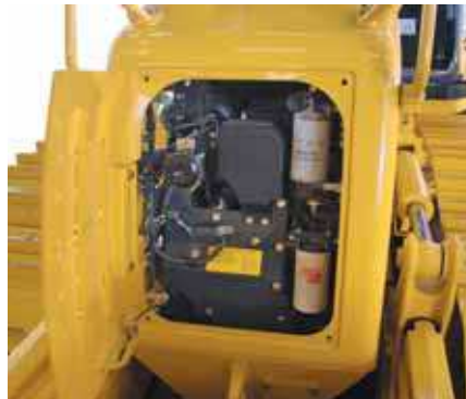
Einmaliger Zugang von vorn
