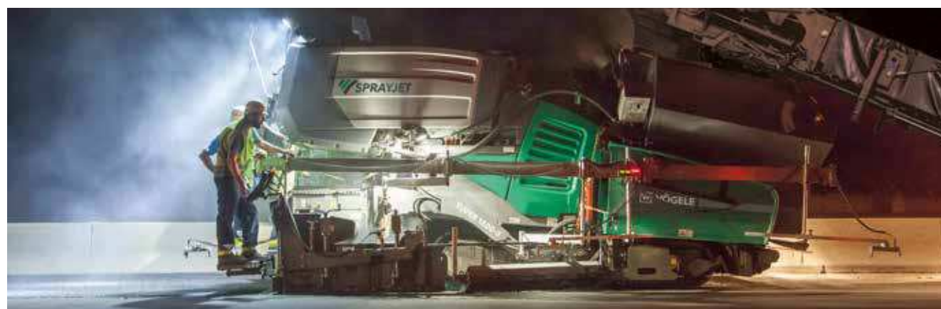
RÉFECTION D'UNE AUTOROUTE
