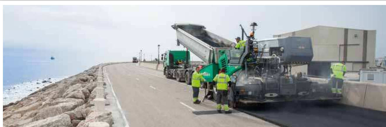
RÉFECTION D'UNE ROUTE DE DIGUE
