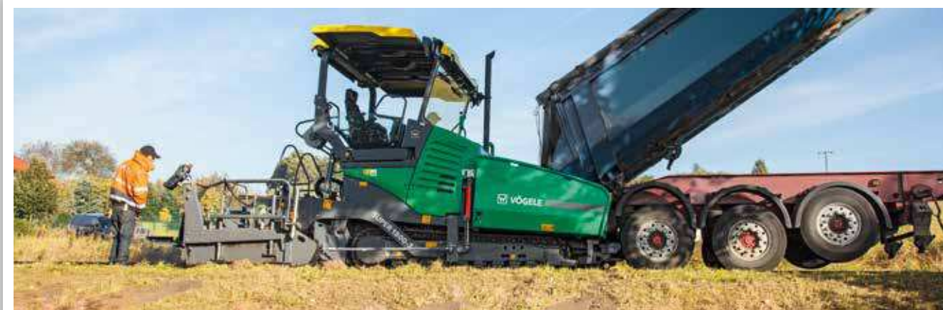
UTILISATION COMME FINISSEUR DE ROUTES CLASSIQUE
