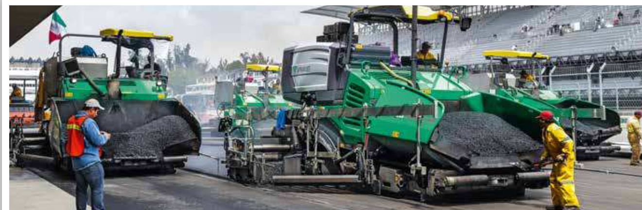
RÉFECTION D'UN CIRCUIT DE COURSE
