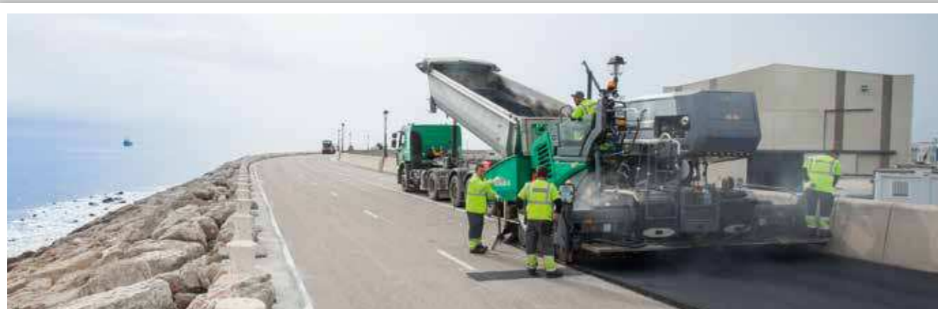
RÉFECTION D'UNE ROUTE DE DIGUE
