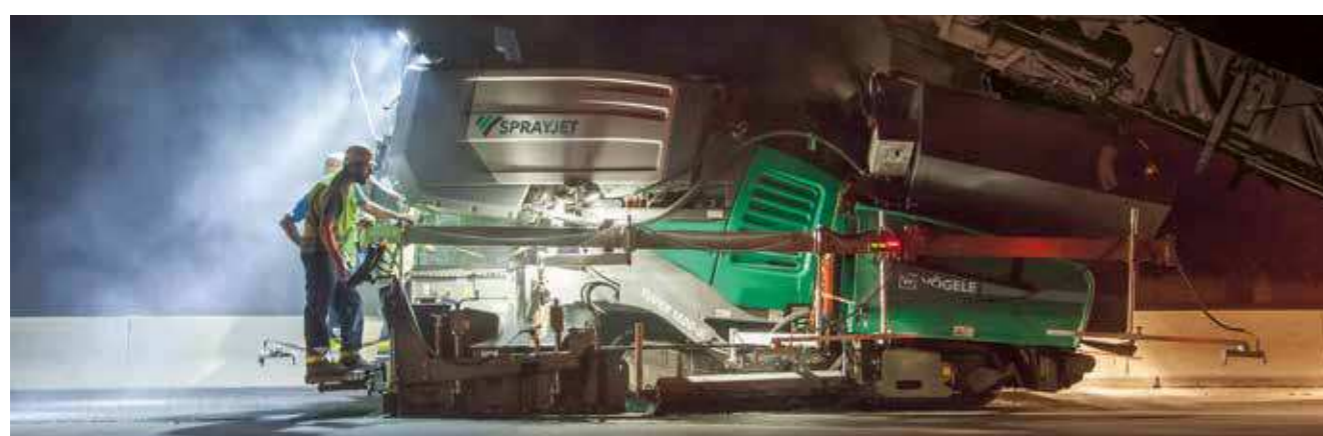
RÉFECTION D'UNE AUTOROUTE
