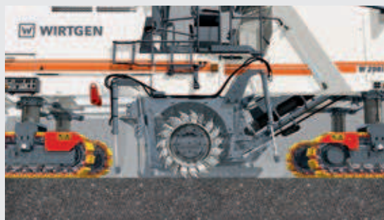
2 | La scarificatrice si abbassa con rapidità rimanendo allineata al fondo stradale
