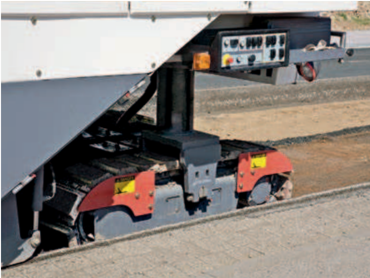
Die Kaltfräse bleibt parallel ausgerichtet.
