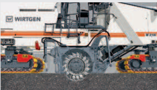
3 | Kaltfräse senkt sich langsam ab und bleibt parallel ausgerichtet
