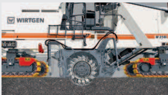
3 | La scarificatrice si abbassa lentamente rimanendo allineata al fondo stradale
