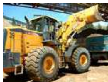
◆ 狭窄区域内施工
