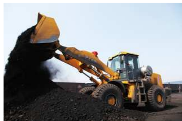
• 徐工LW600K-LNG装载机港口施工
