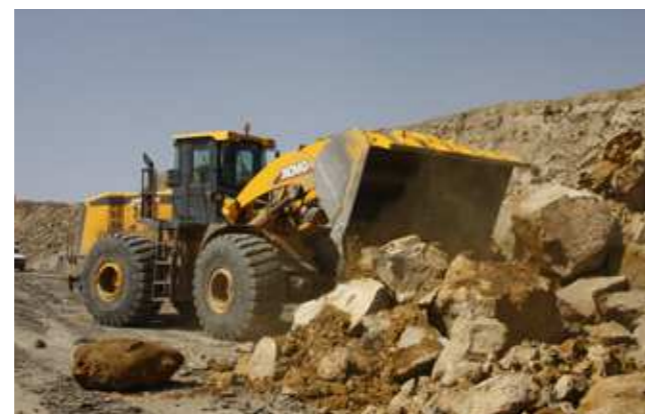
• 徐工LW800K装载机恶劣工况施工
